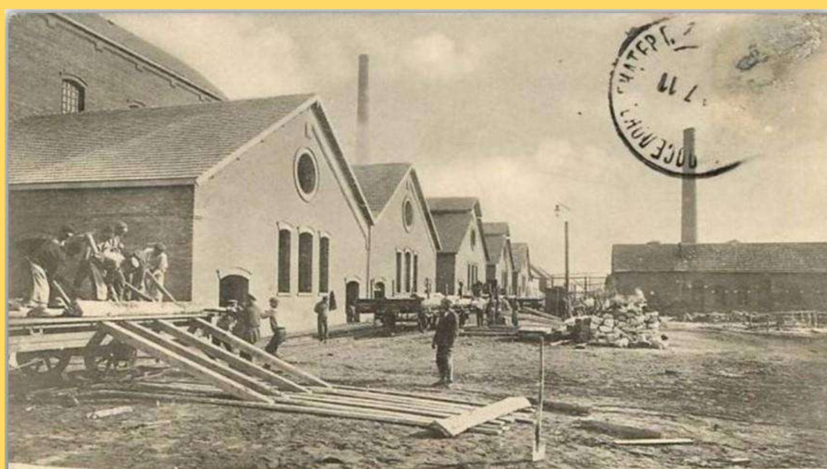
Химический завод. Вид внутренних фасадов. Общество Донецких Стекольных Заводов. Константиновка, Екатеринославской губ.
