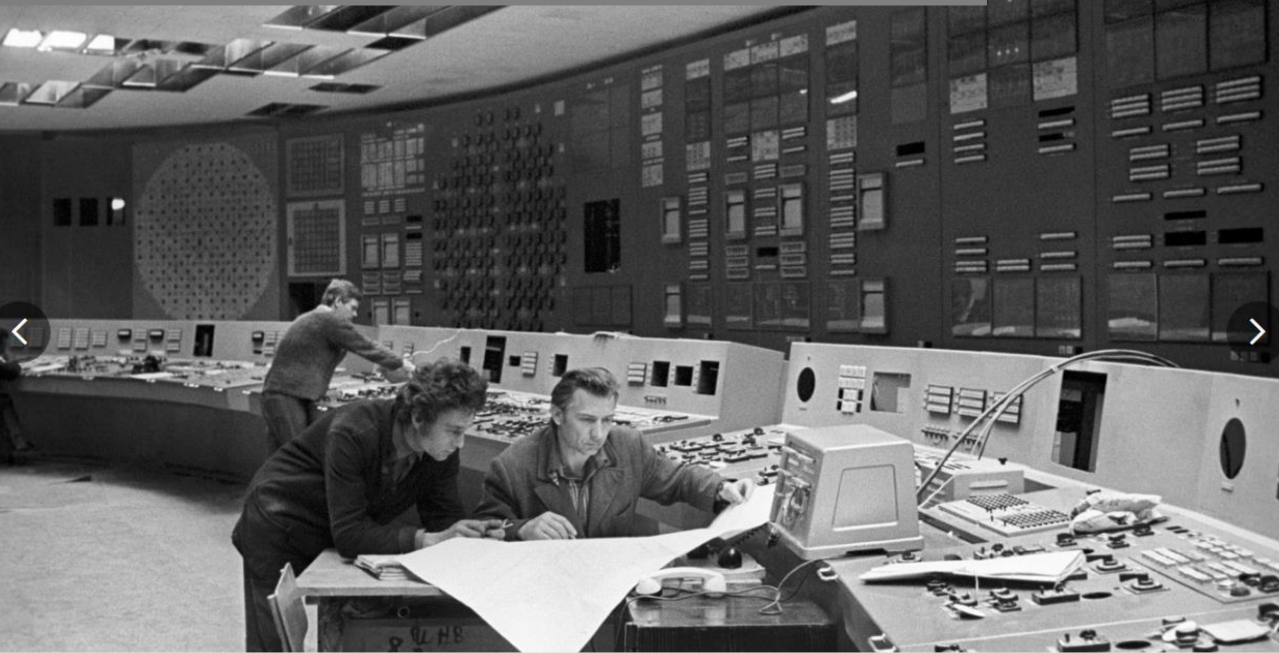
Монтажні роботи на пульта управління Чорнобильської АЕС. 23 травня 1977 року. В. Лисенко/Фотохроніка ТАСС
